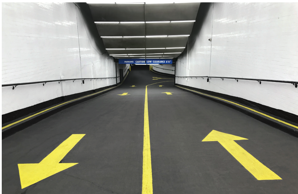
Rampes en béton lisse avec tapis à rugosité contrôlée.
