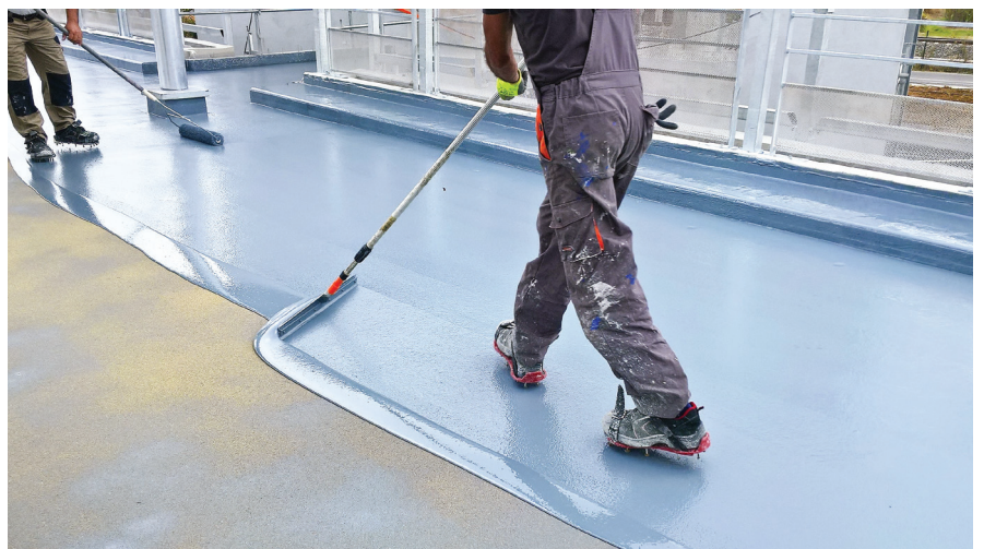
Couche de garnissage ou finition INFRAPUR FINISH 2046
