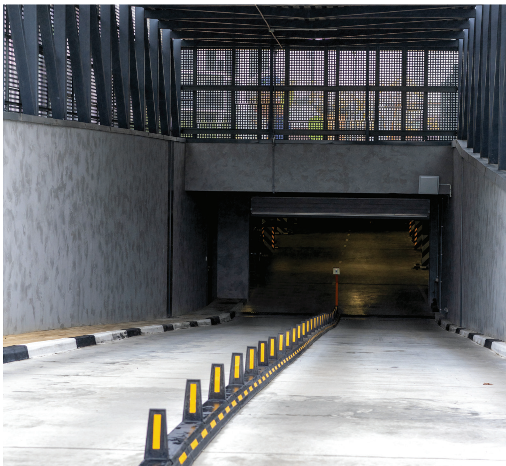
Rampes en béton lisse avec tapis à rugosité contrôlée.
