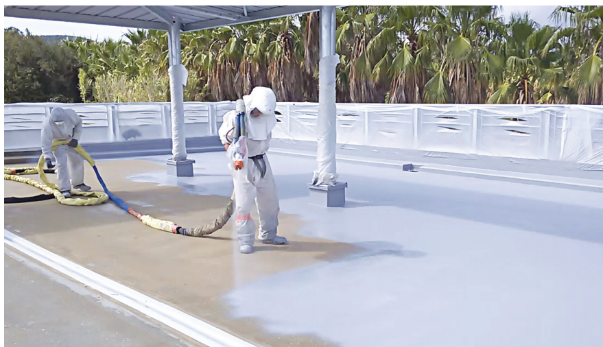
Étanchéité membrane INFRAPUR WP 411 SPRAY (pose à l'airless)
